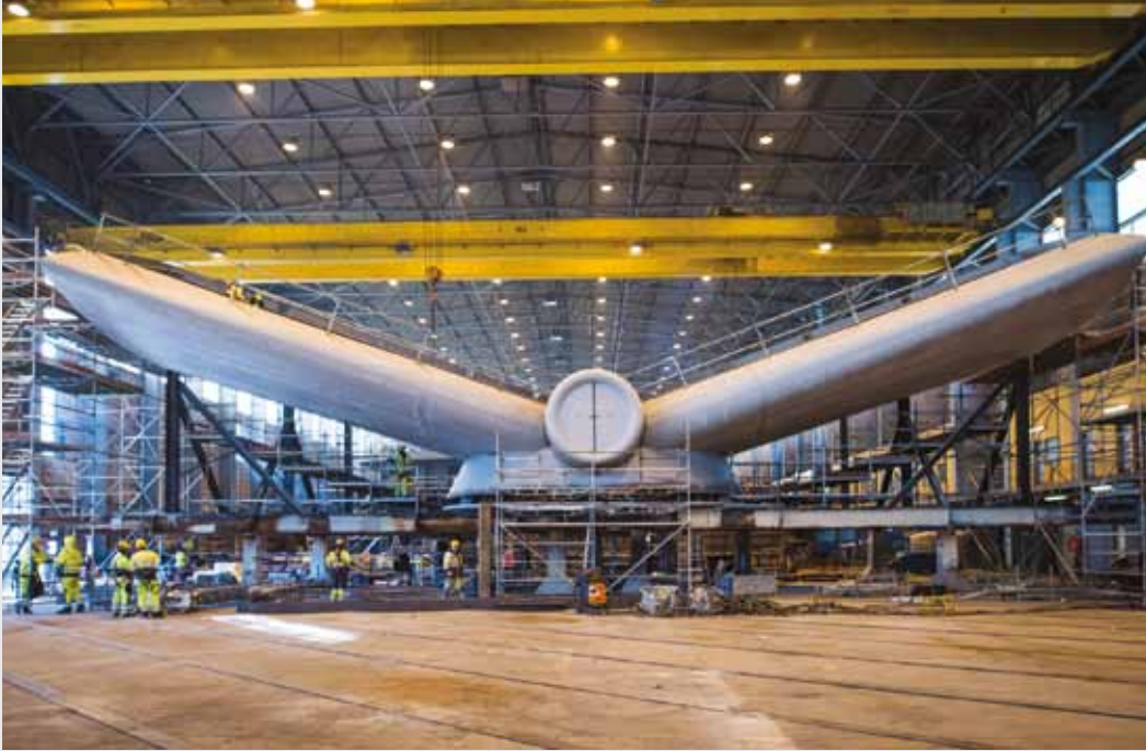
Laivan savupiipun rakentamista Meyerin telakalla Turussa.
